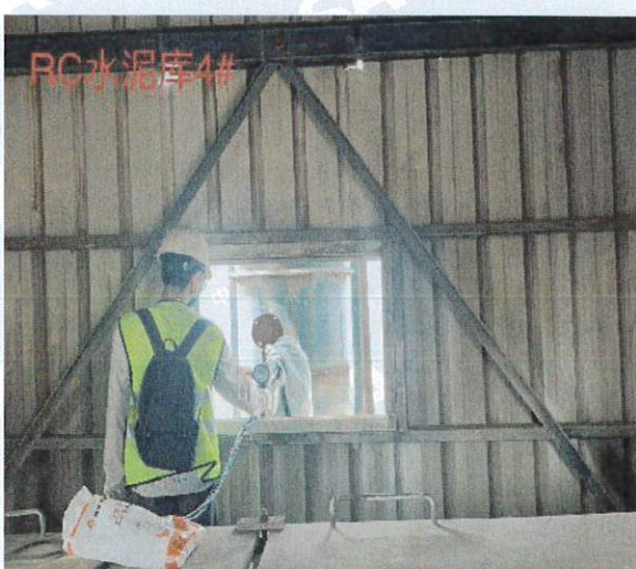
DA037 4#RC 水泥库
